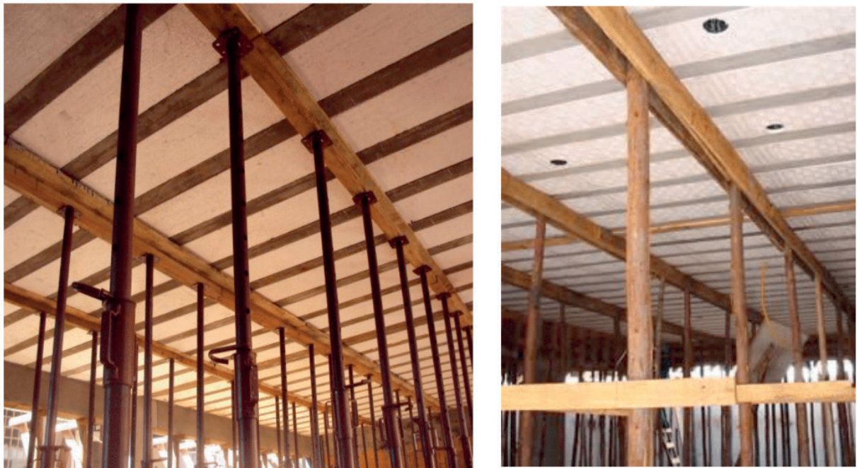
Figura 1 - Laje treliçada apoiada por escoras e longarinas
