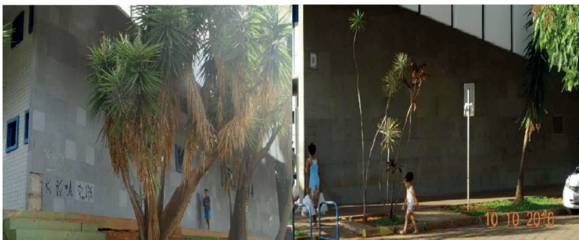
Figura 04 – Revestimento em granito nas fachadas norte (esquerda) e sul (direita).
