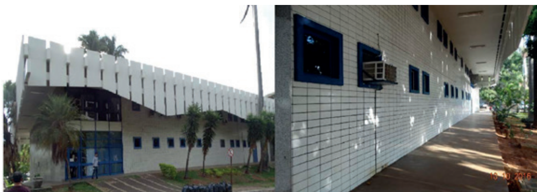
Figura 03 – Revestimento gail nas fachadas leste (esquerda) e oeste (direita).
