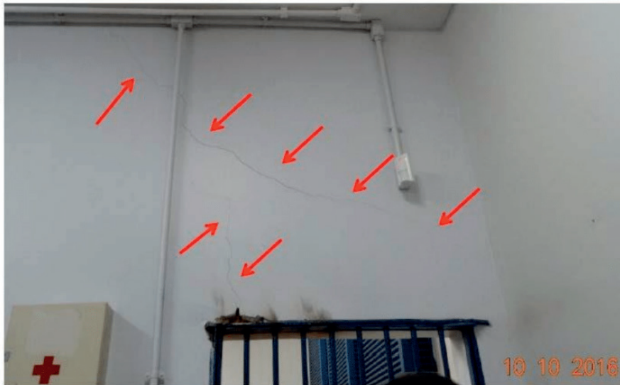
Figura 10 – Alvenaria externa acima da porta de segurança da sala do cofre.
