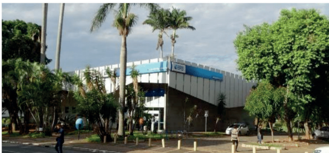
Figura 02 – Fachada frontal da Agência do Banco do Brasil.
