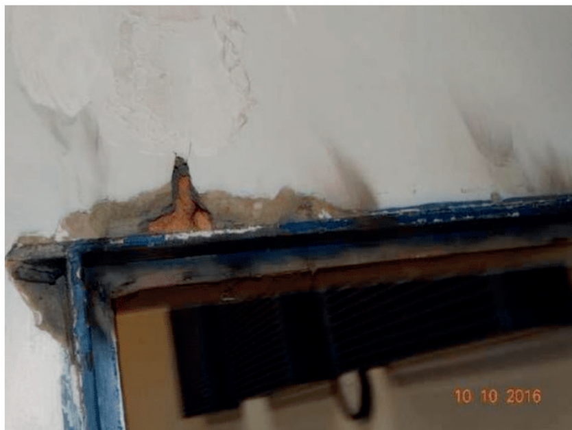
Figura 11 – Porta de entrada ao cofre sem verga.
