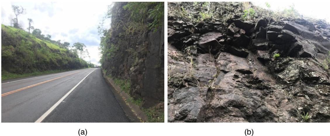
Figura 8 – Rodovia BR-376 km 241+25 LD/LE (a) vista do talude rochoso (b) detalhe de uma porção desse talude, sem ocorrência de deslocamento ou queda de bloco rochoso.
