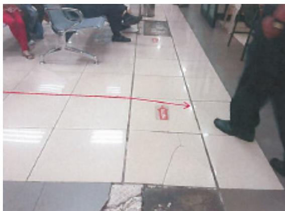
Figura 5: Rachaduras excessivas em pisos.
