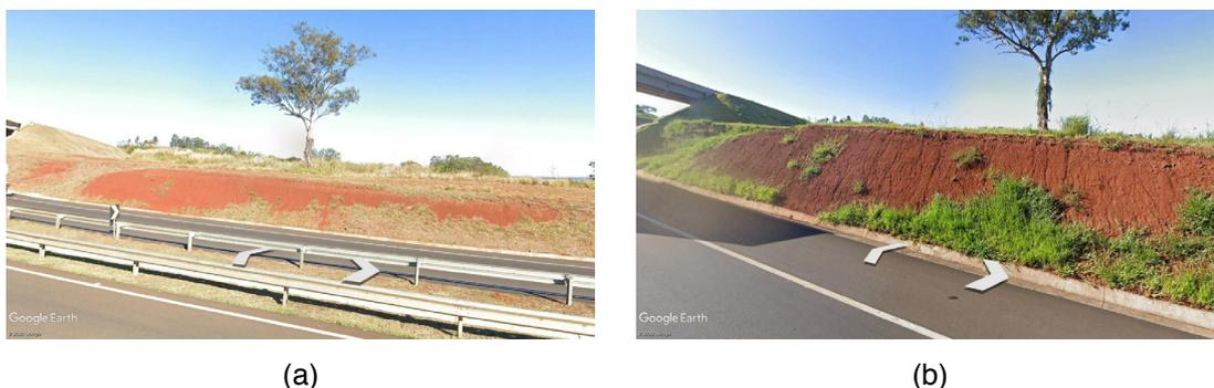
Figura 13 – (a) Talude terroso no trecho estudado da BR-376 km 244+310 LD (b) presença de pequenos sulcos na face do talude.
