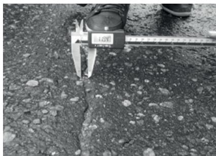
Figura 1 – Fenda do tipo trinca - Av. Procópio Rola (Autores (2018))
