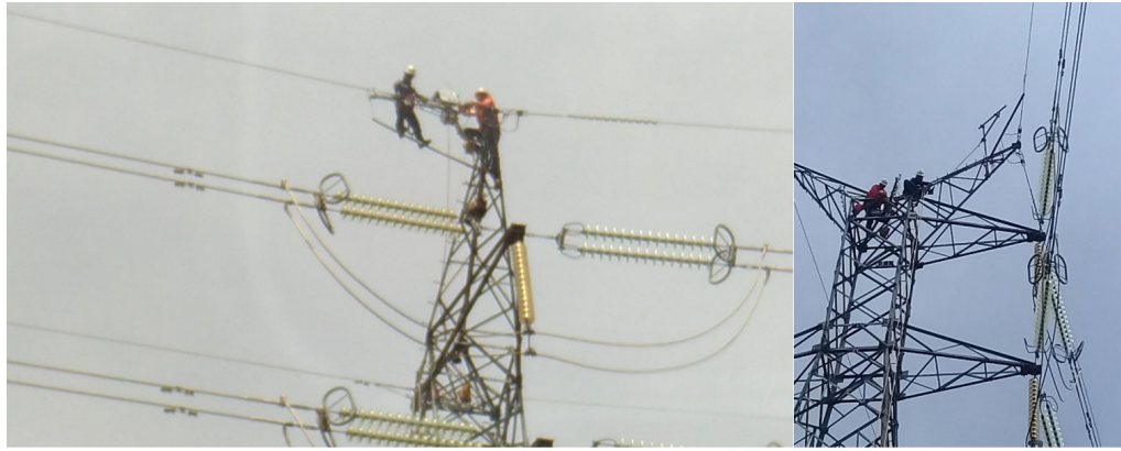
Figura 7: Teste na linha energizada - Porto Primavera.
