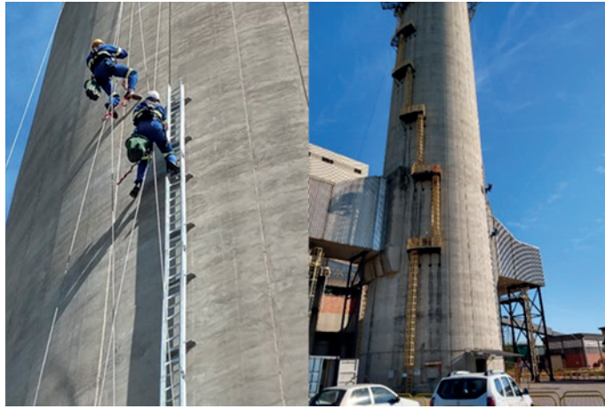
Figura 6. Alpinistas industriais realizando a instalação do sistema de bandejamento.
