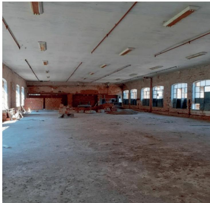
Fotos 13 – Intervenção dentro do prédio para a construção de laboratórios e salas de aula, com alteração das características construtivas original.
