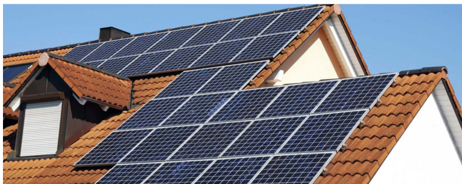
Figura 2 – Painéis fotovoltaicos instalados em residências – método convencional
