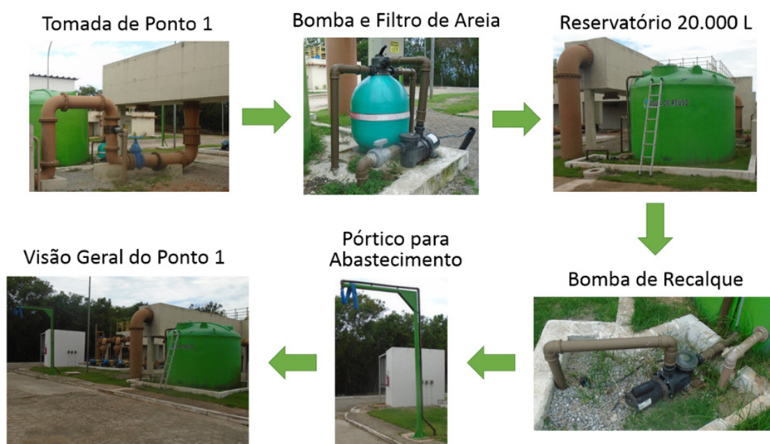
Figura 2. Sistema de tratamento da água de reuso.
