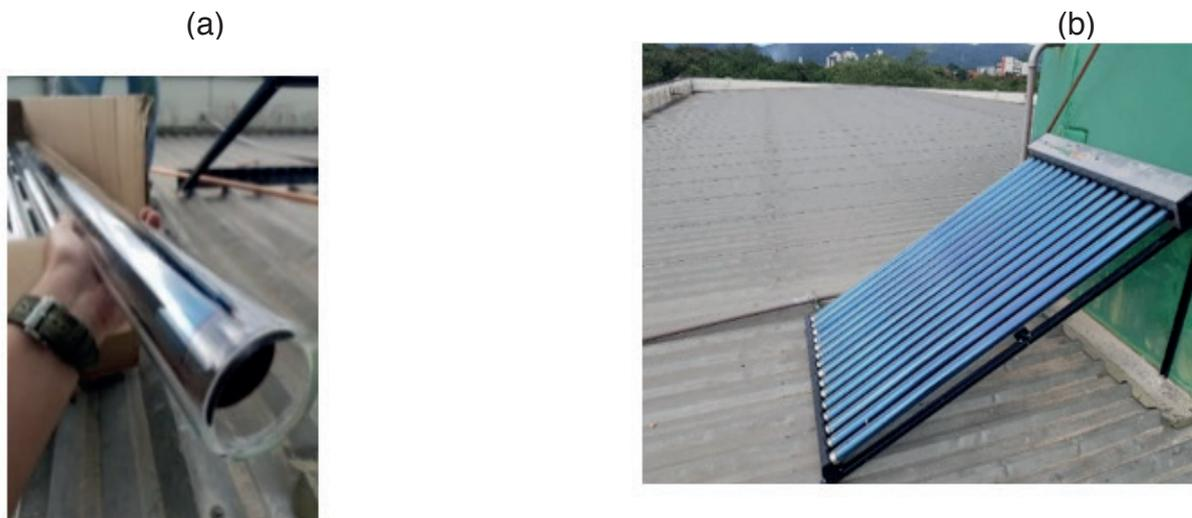
Figura 5 – (a) Tubo à vácuo ; (b) Sistema de aquecimento solar tubular à vácuo instalado.
