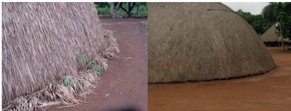
Figura 5 – Cobertura de sapé antes e depois de aparada
