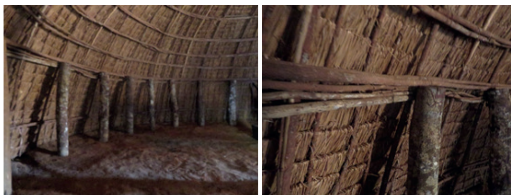
Figura 3 – Viga de feixes de madeira apoiada sobre os pilares perimetrais
