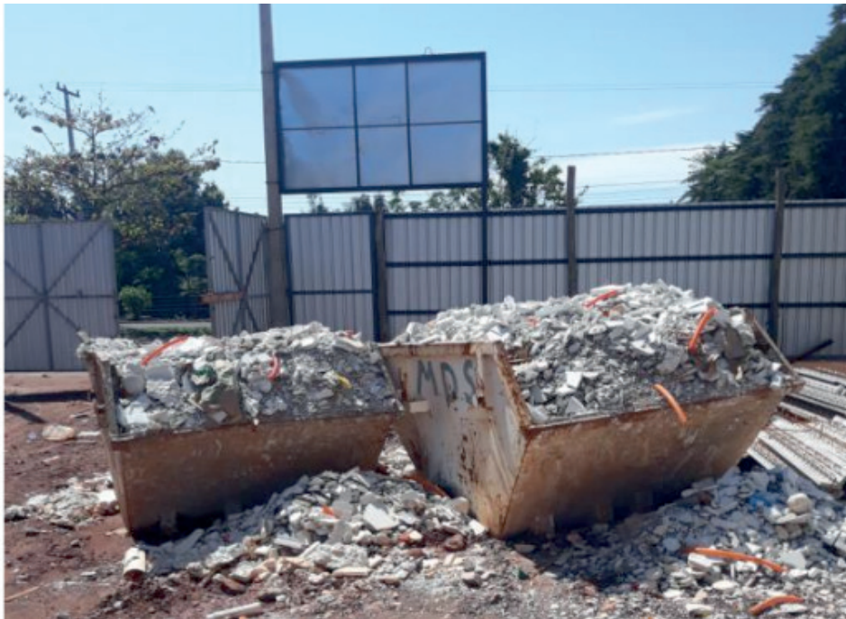
Figura 6. Disposição de resíduos em caçambas metálicas
