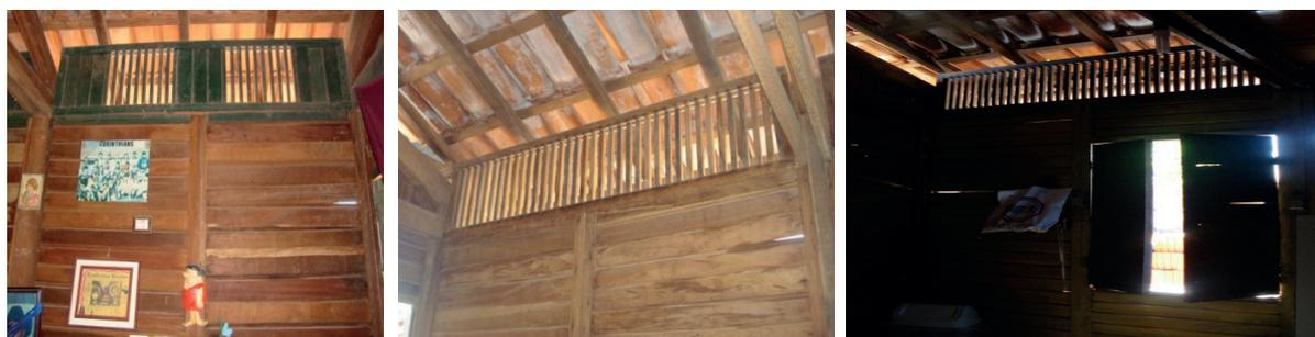
Figura 4 - Painéis de ventilação em bom estado.
