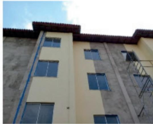
Figura 2 – Fachada oeste com pintura não finalizada
