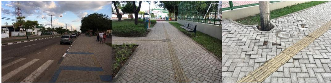
**Figura 7** – Via de intenso fluxo, passeios largos, pisos táteis e patologias.
