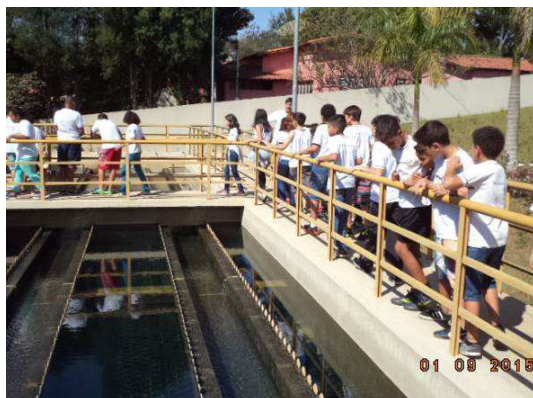
Figura 2. Visita realizada à ETA.
