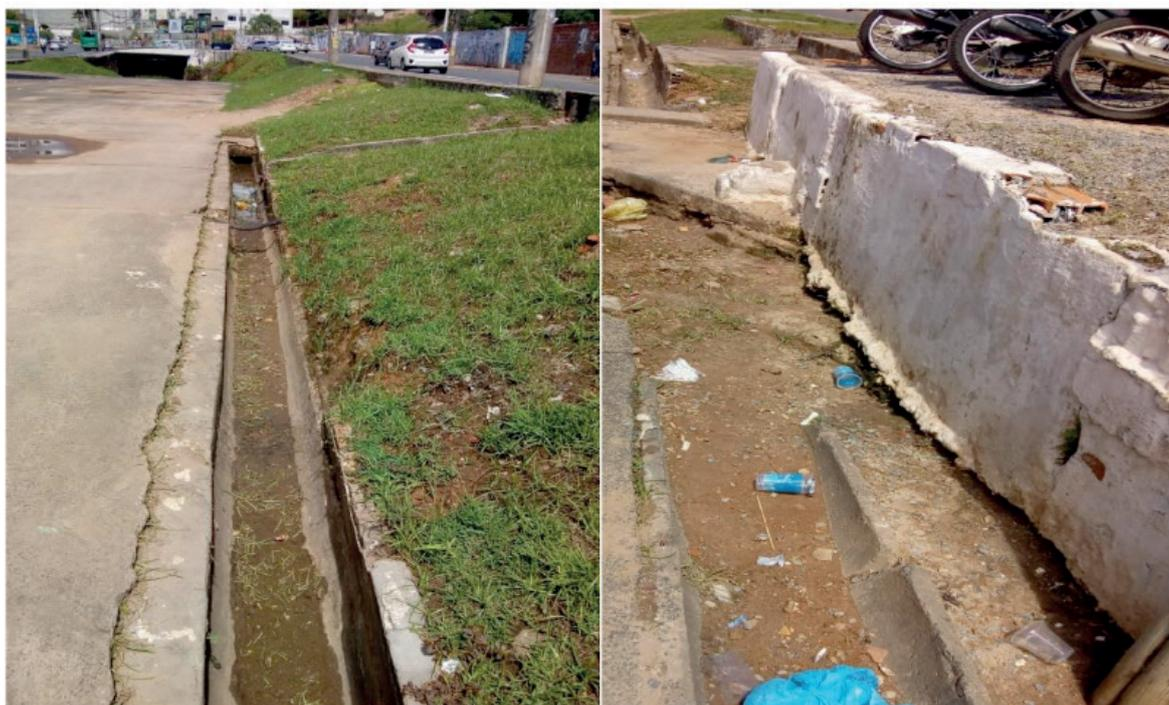
Figura 10 – Canais coletores de águas pluviais deteriorados
