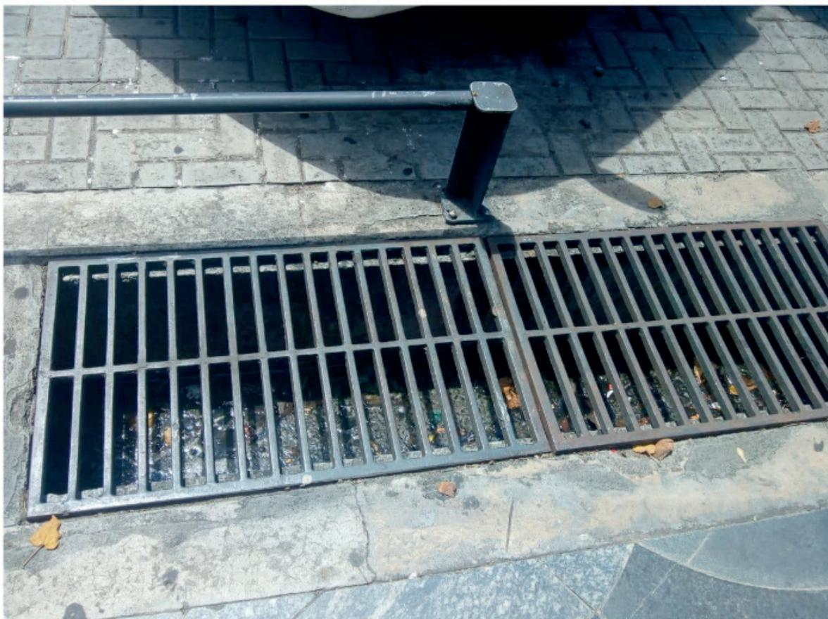
Figura 13 – Dispositivo de captação das águas pluviais no Largo da Mariquita
