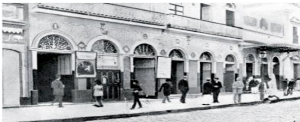
Figura 3. Cinema Pathé, inaugurado em 1909, na Rua Nova.
