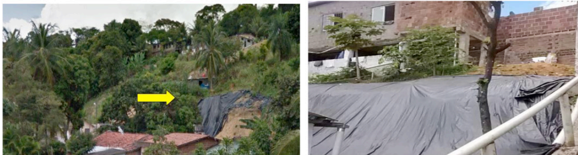
Fotos 1 e 2: Lona preta, muito usada pela Defesa Civil para evitar infiltrações de água: Alto do Maracanã.
