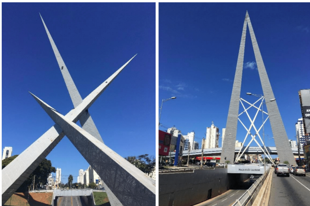
Figura 2-A imagem da esquerda refere-se ao Viaduto Latif Sebbá; e a imagem da direita refere-se ao Viaduto João Alves Queiroz.
