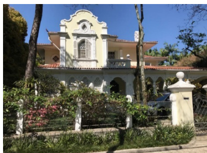
Figura 4: Residência Neocolonial Rua Peru, 71
