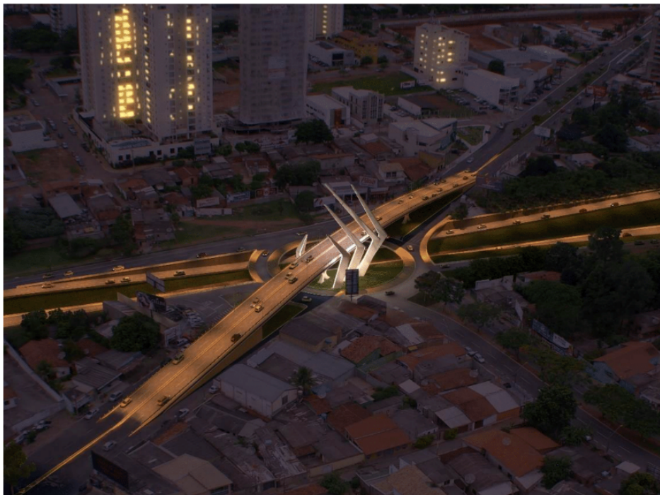
Figura 3–Viaduto Jamel Cecílio, em Construção. Imagem divulgada em 2015.
