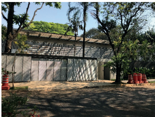
Figura 11: Construção contemporânea Rua Doutor Ibsen da Costa Manso, 182
