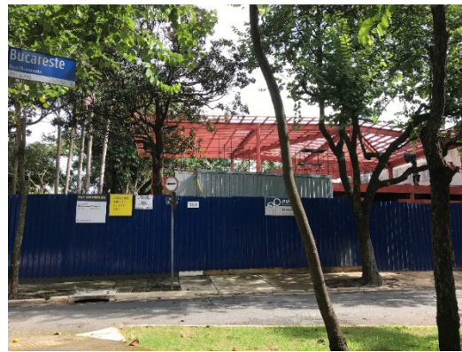
Figura 14: Construção recente (estrutura metálica). Rua Bucareste, 388.
