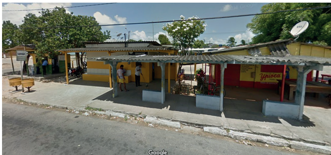
Figura 3. Terminal de ônibus com abrigo.
