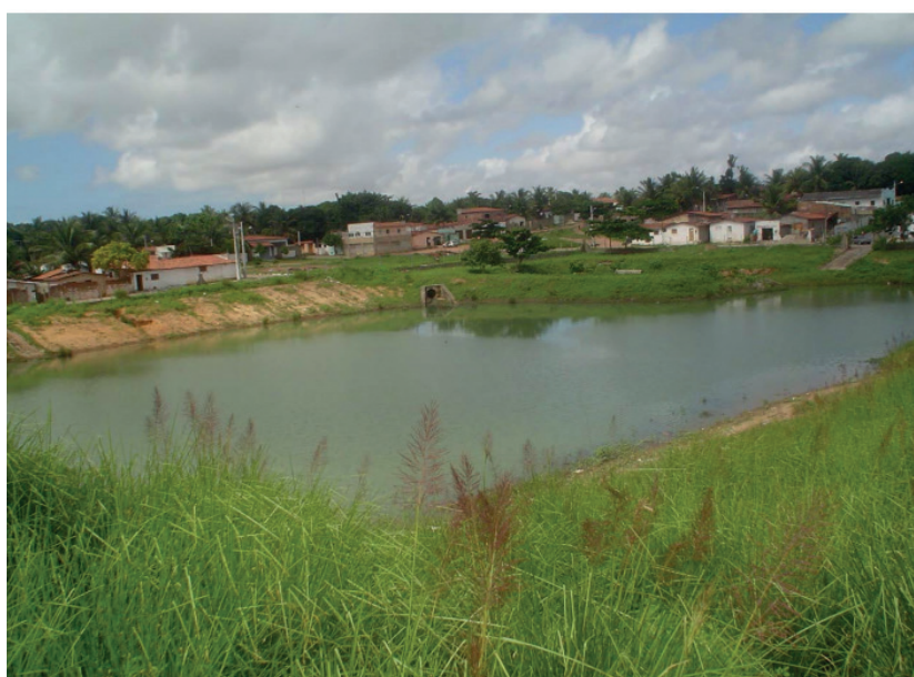
Figura 2. Lagoa de captação das águas pluviais no conjunto Pajuçara
