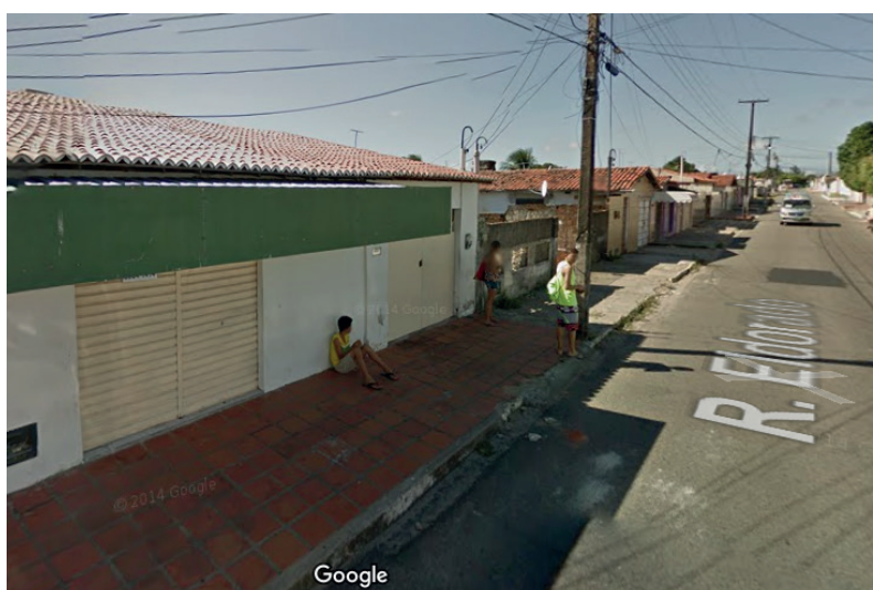
Figura 2. Parada de ônibus sem abrigo.
