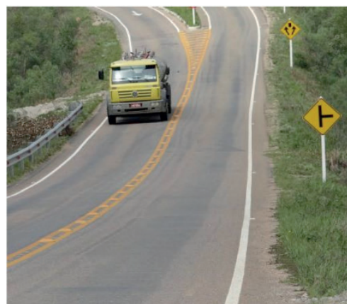
B - Defesa Metálica
