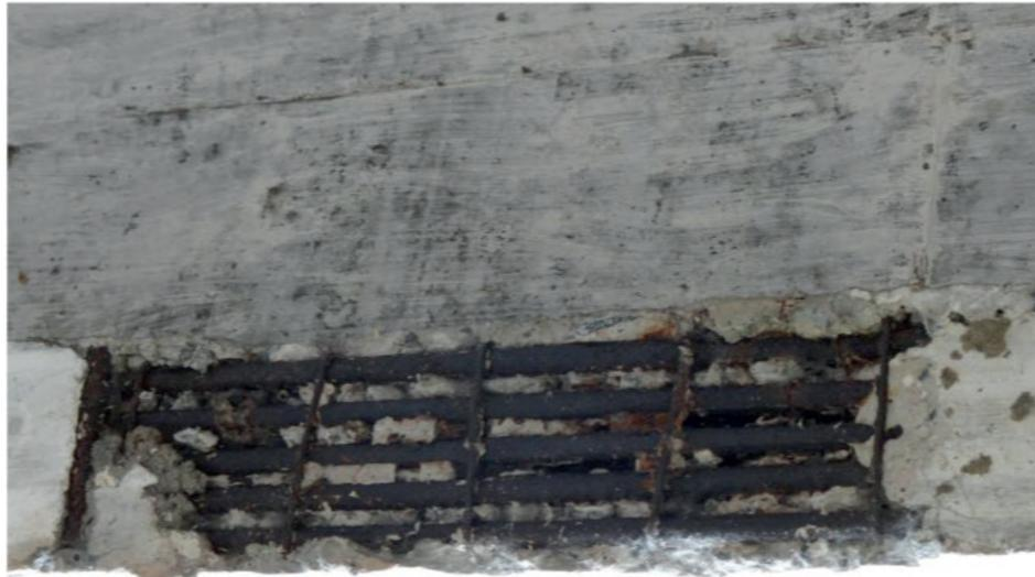
Figura 2 - Longarina com armadura exposta, de nicho de concretagem e corrosão
