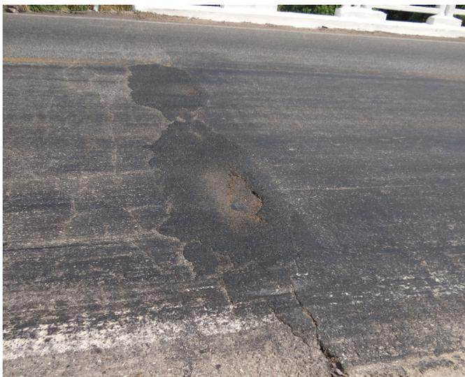
Figura 4 – Desnível na entrada da ponte
