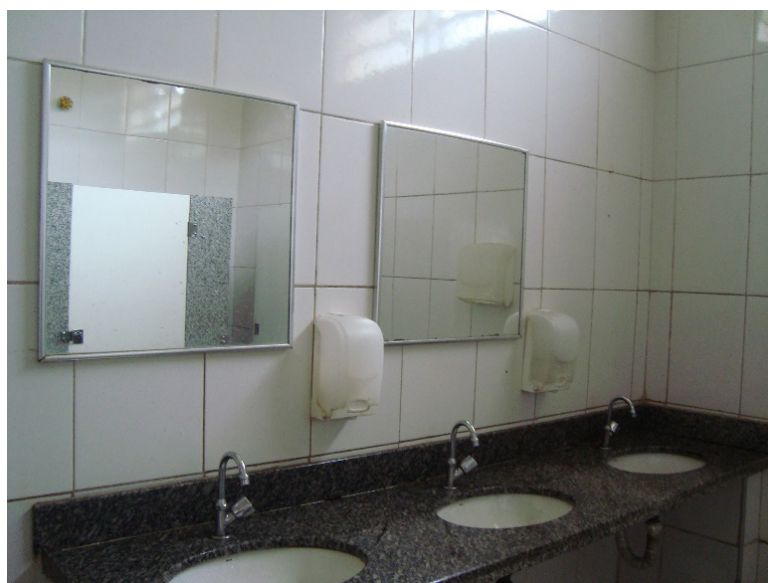
Figura 11 – Lavatório banheiro masculino
