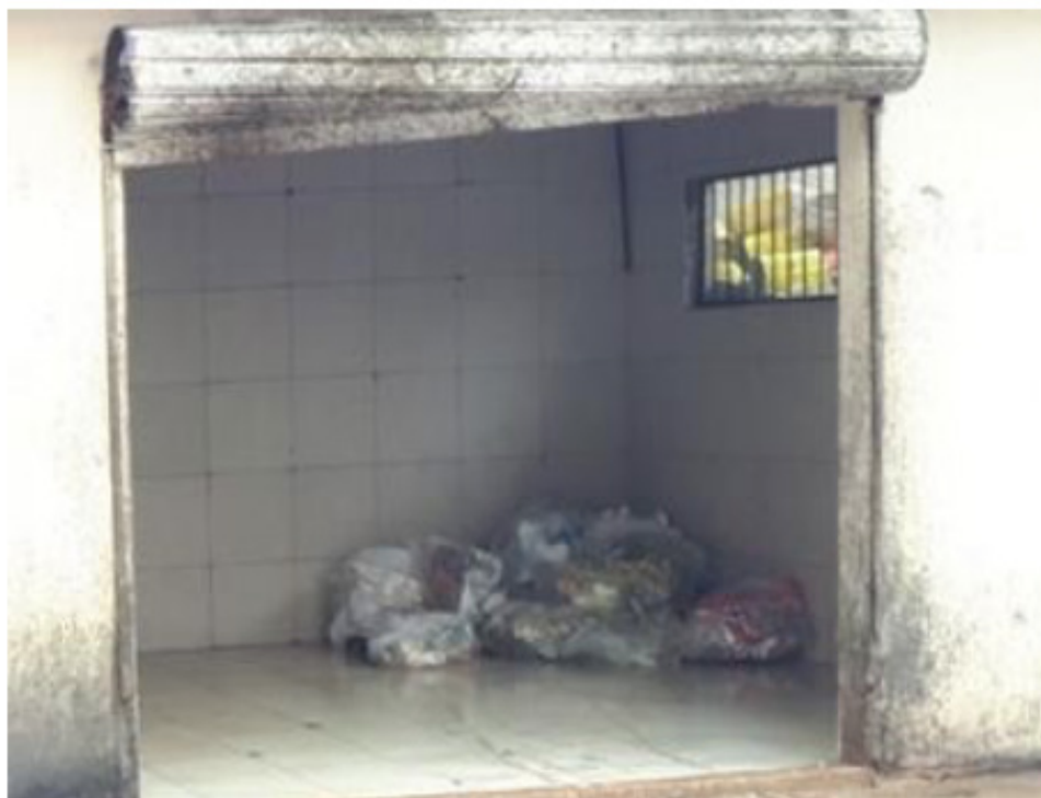
Figura 1: Depósito de armazenamento dos resíduos sólidos (2ª unidade)
