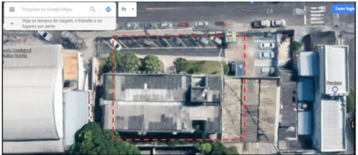
Figura 1 - Vista de cima do prédio de administração da PRODAM
