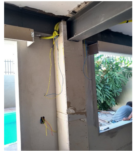
Figura 03: Execução do Pilar Fonte: Autoria Própria
