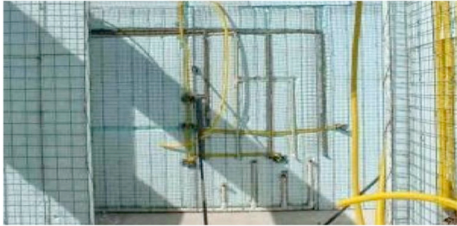
Figura 9 - Traçados feitos para instalação elétrica e hidráulica
