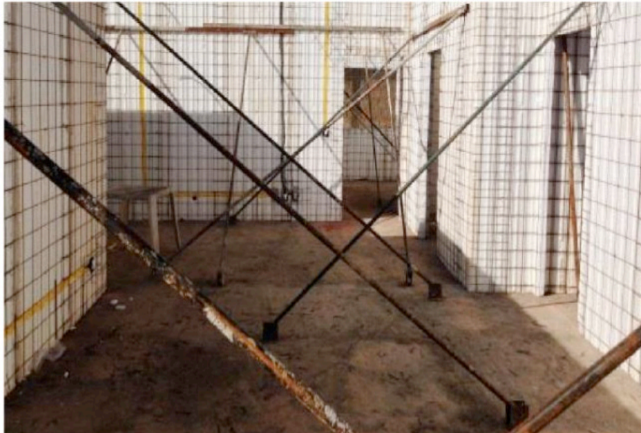
Figura 8 - Detalhe das réguas e escoras
