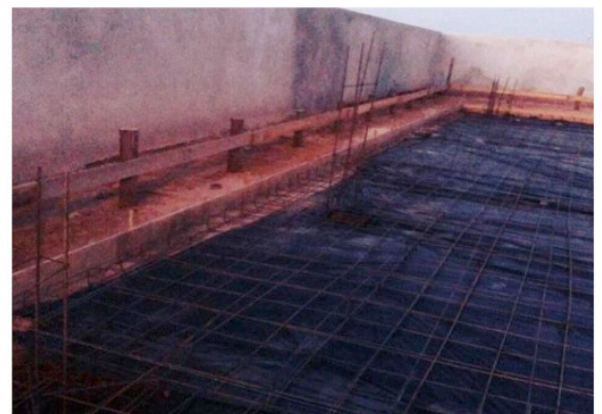
Figura 2 - Radier pronto para concretar
