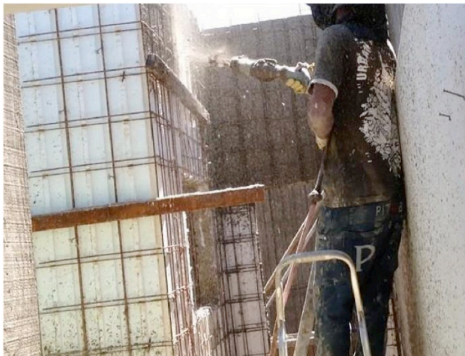
Figura 11 - Revestimento das Paredes
