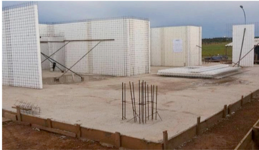
Figura 5 - Fixação dos Painéis
