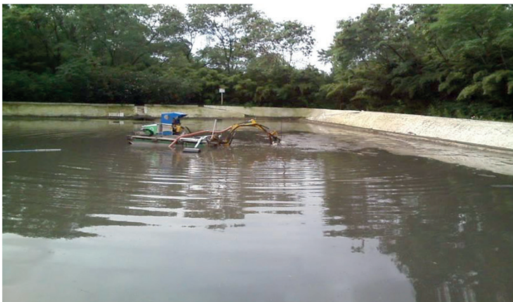
Figura 6. Lagoa de sedimentação da ETE Valparaíso.
