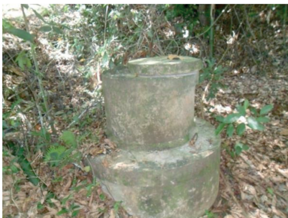
Figura 2: Interceptor para coleta de esgoto.
