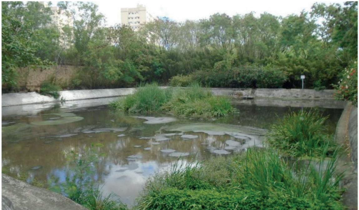
Figura 1. Lagoa de sedimentação da ETE Valparaíso – Lodo em excesso e vegetação.
