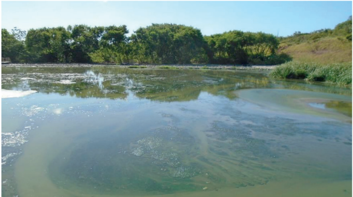
Figura 2. Lagoa de polimento da ETE Civit II – Lodo em excesso e vegetação.
