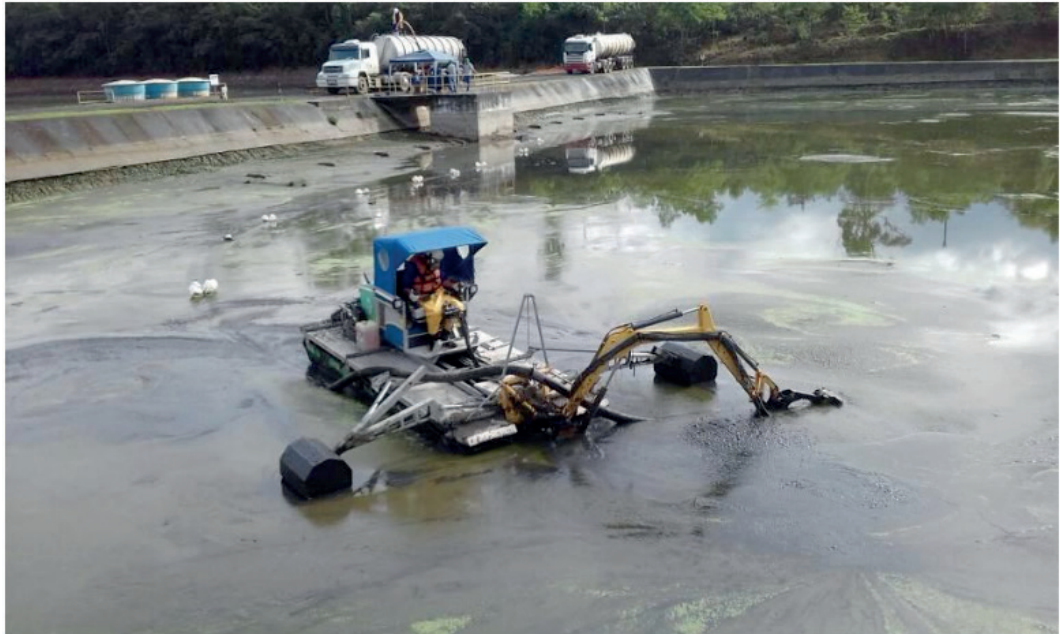
Figura 4. Máquina anfíbia removendo lodo da lagoa de polimento da ETE Civit II e os caminhões utilizados no transporte.
