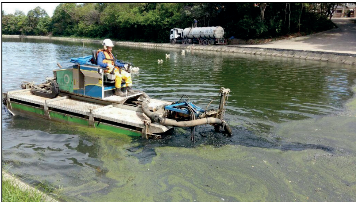
Figura 3 - Operação de dragagem de lodo na ETE.
