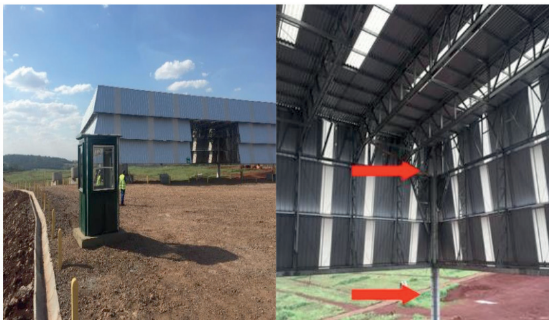
Figura 3 – Sistema de captação de água da chuva
