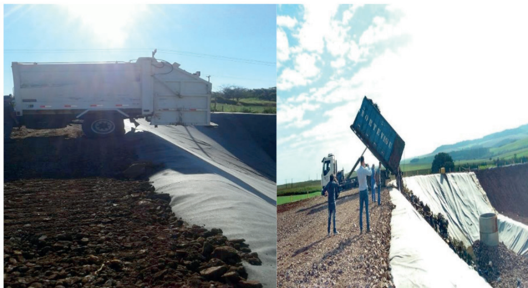
Figura 4 – Disposição final dos resíduos nas valas
