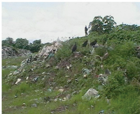
Figura 6: Taludes e a presença de aves
