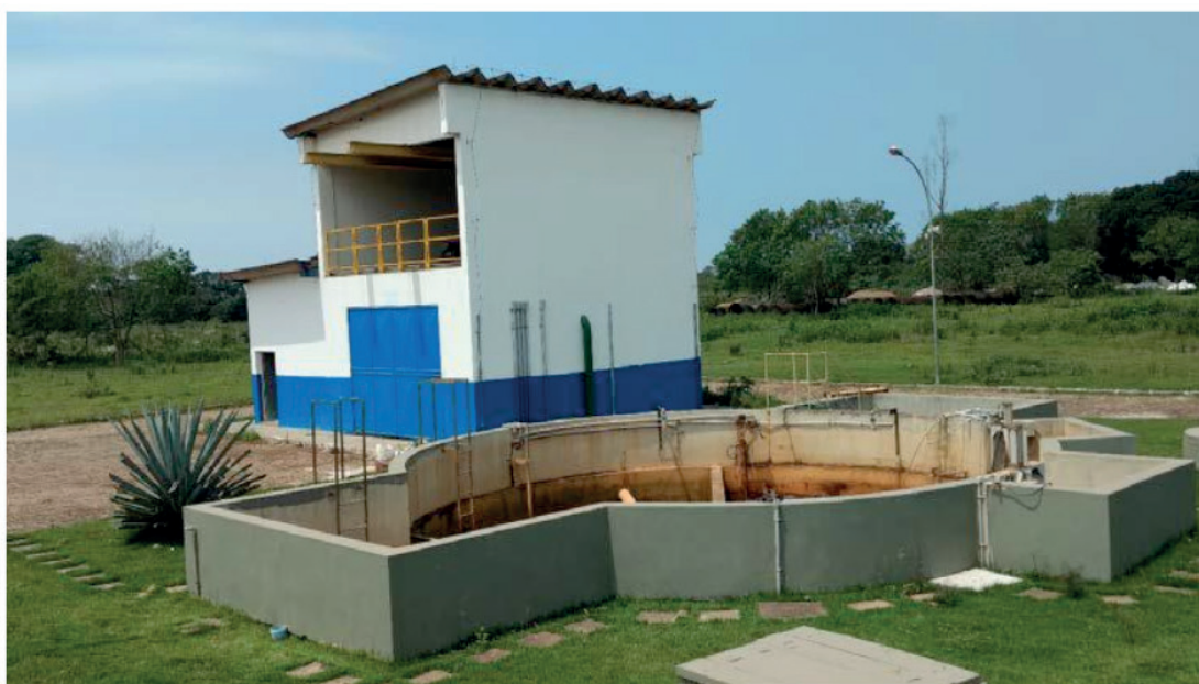
Figura 1: Vista da estação de desidratação de lodo Caçaroca fechada para manutenção.
