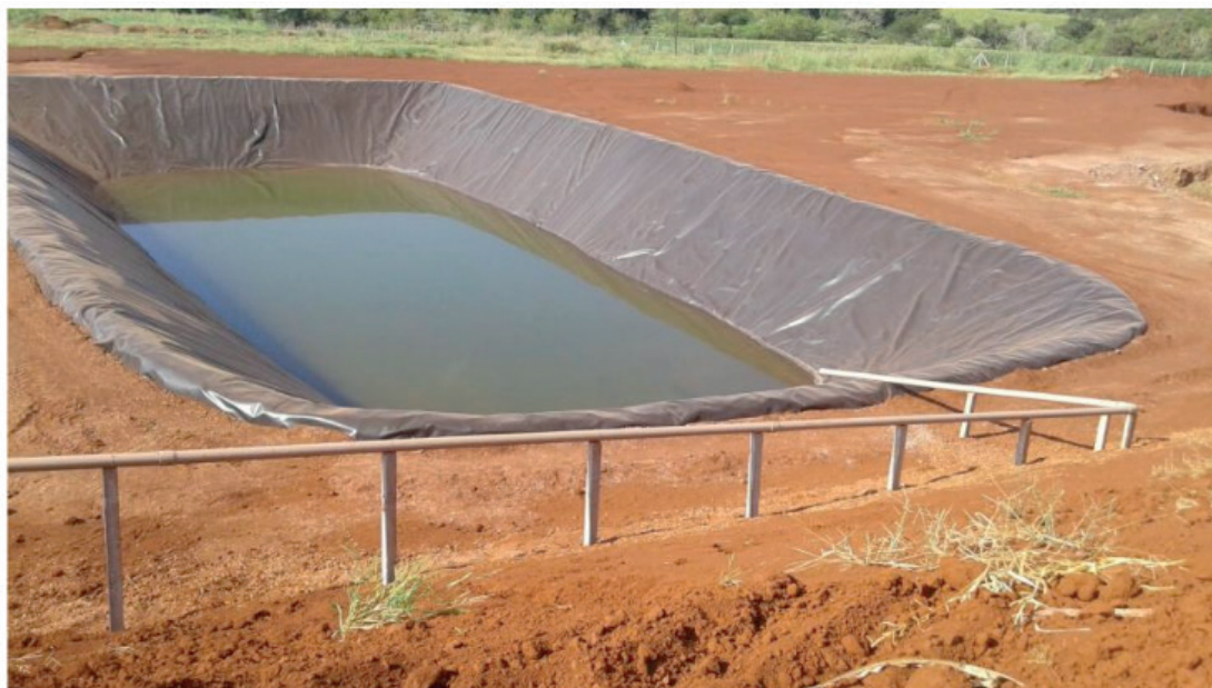
Figura 2 – Lagoa de lixiviado
