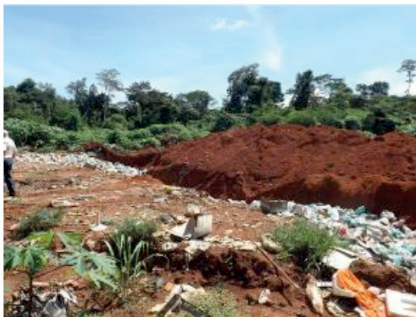
Foto 04: Área do lixão de Cabixi Autor: FERRETE, 2015
