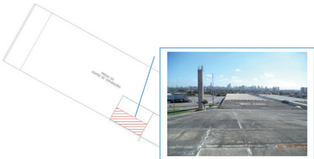
Figura 9 - Vista superior do telhado da EMPETUR onde a área em vermelho seria destinada a captação de água pluvial.
