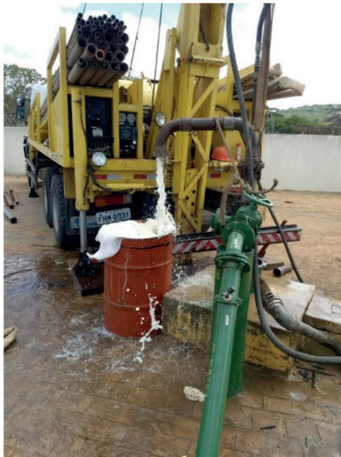
Figura 04 – Equipamento de limpeza realizando o descarte do material utilizado
