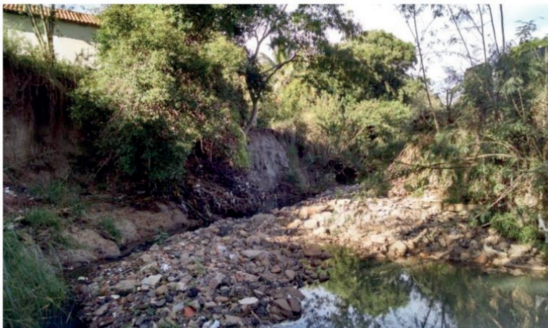
Figura 9 – Assoreamento no córrego Afonso XIII – braço esquerdo
