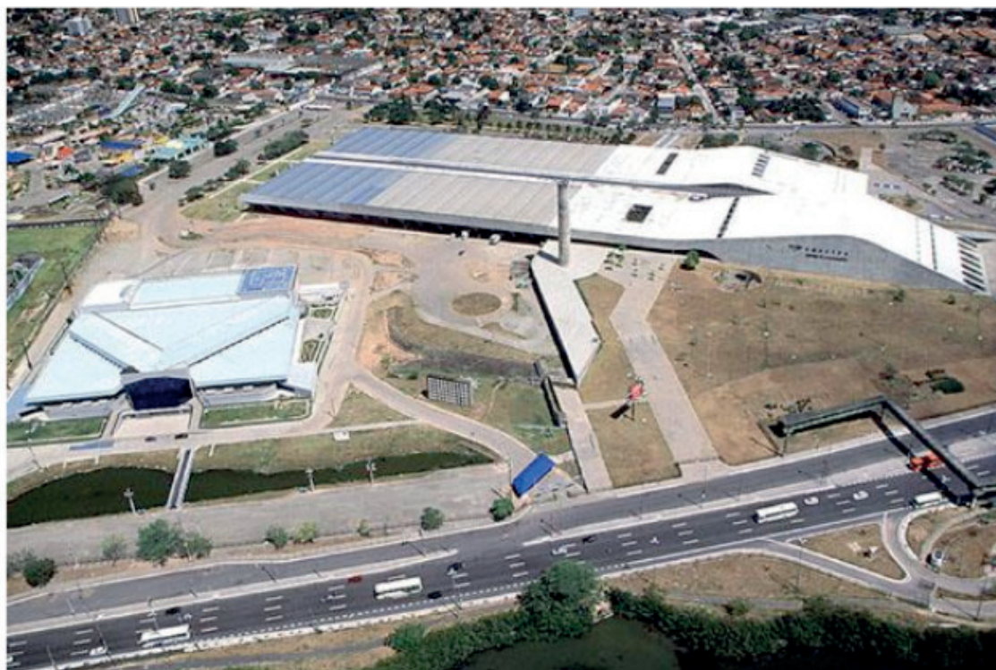
Figura 2 – Vista área do Centro de Convenções de Pernambuco localizado em Olinda (PE).
