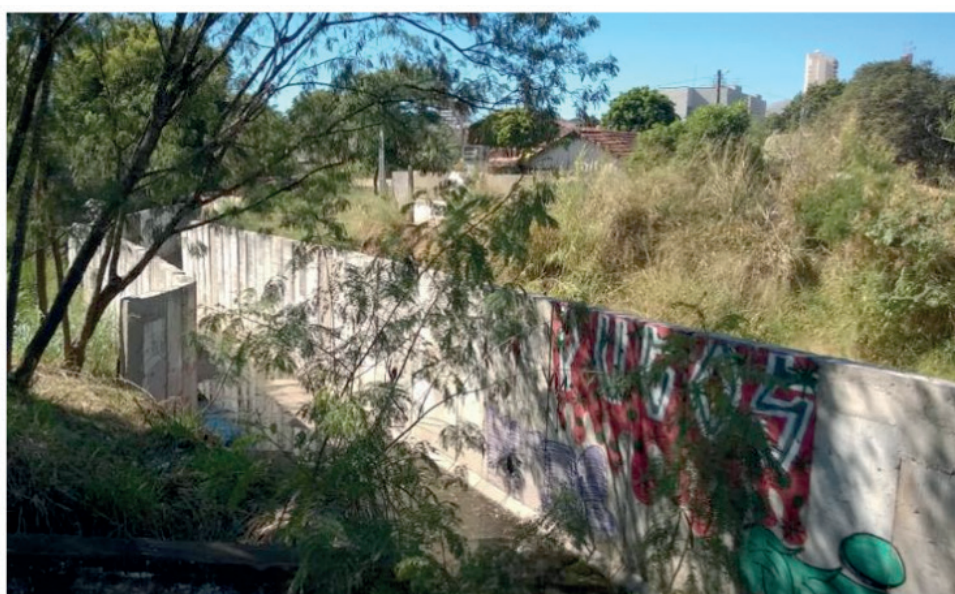
Figura 12 – Canalização vista da Rua Manoel F. Damião.
