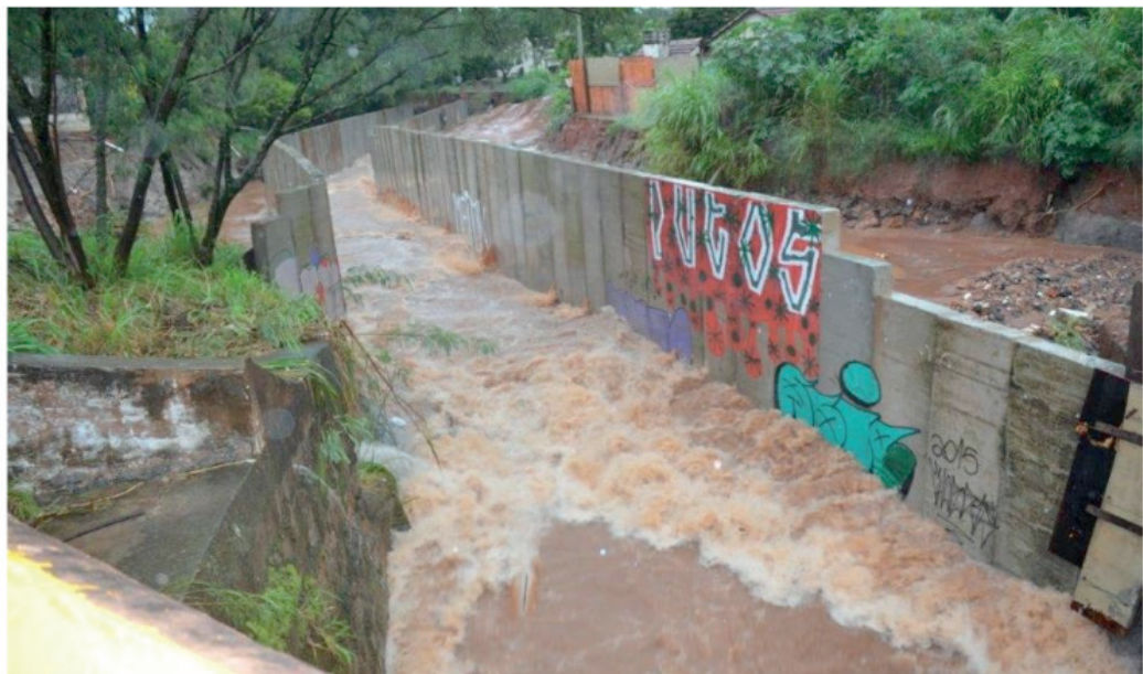
Figura 14 – Canalização vista da Rua Manoel F. Damião.
