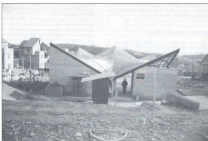
Figura 5: Canteiro de obras/Centro Comunitário do Jardim São Francisco 8
