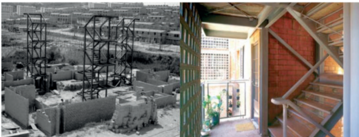
Figura 16: Mutirão União da Juta – USINA. Torres de escadas metálicas que serviram de prumo e nível e permitiram a construção das unidades habitacionais ao seu redor com precisão.
