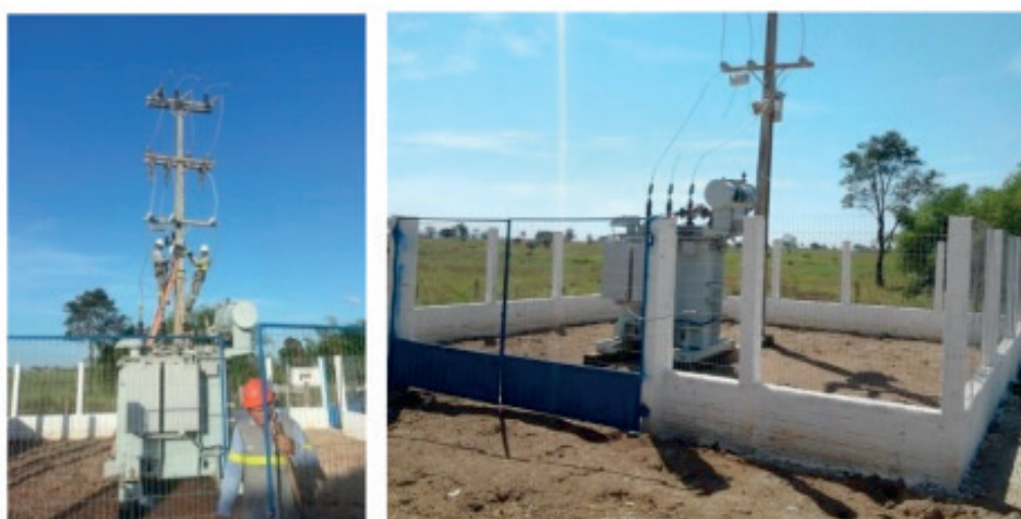
Fig.5. Fotos da instalação do transformador de aterramento
