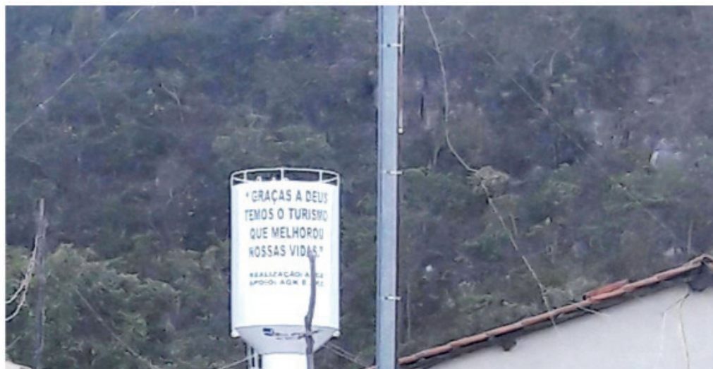
Figura 10: Fotografia da caixa d’água de Agradecimento
