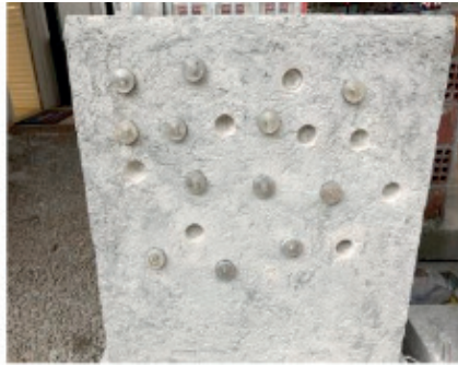
Figura 6 – Pastilhas coladas na parede
