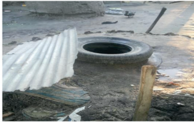
Figura2: Poço sem proteção adequada.
