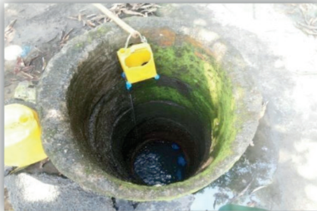
Figura 3: Poço com a borda cimentada mas sem proteção.
