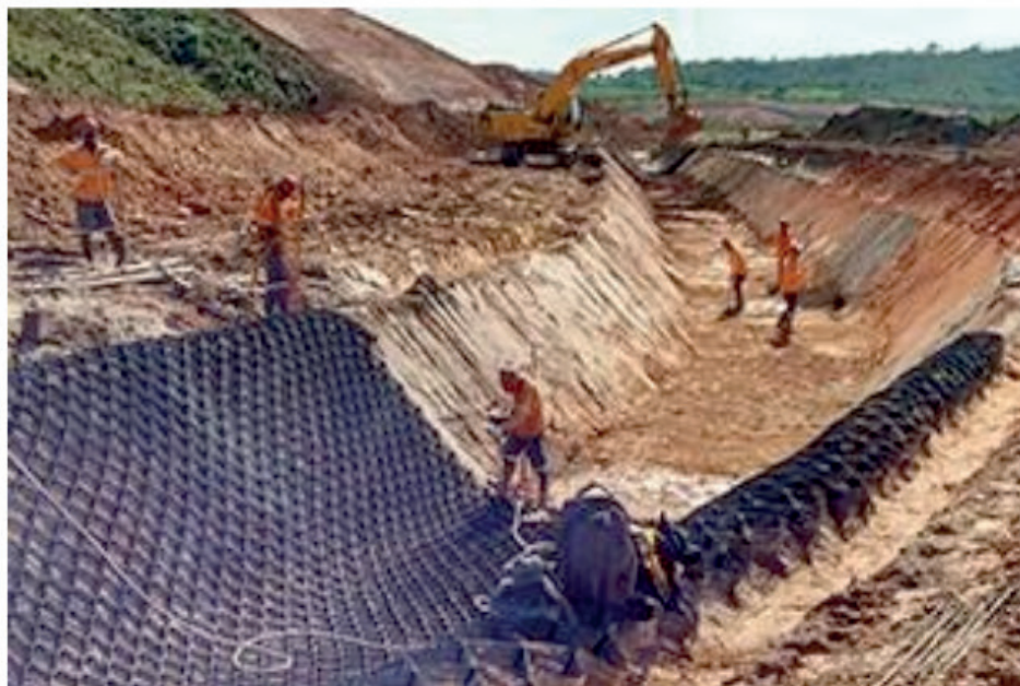
Figura 1 – Revestimento de canais utilizando geocélula. Fonte: TDM.
