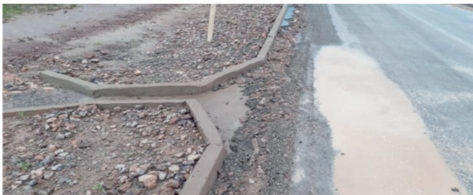
FIGURA 11 – Sarjeta de aterro, saída d'água, descida d'água
