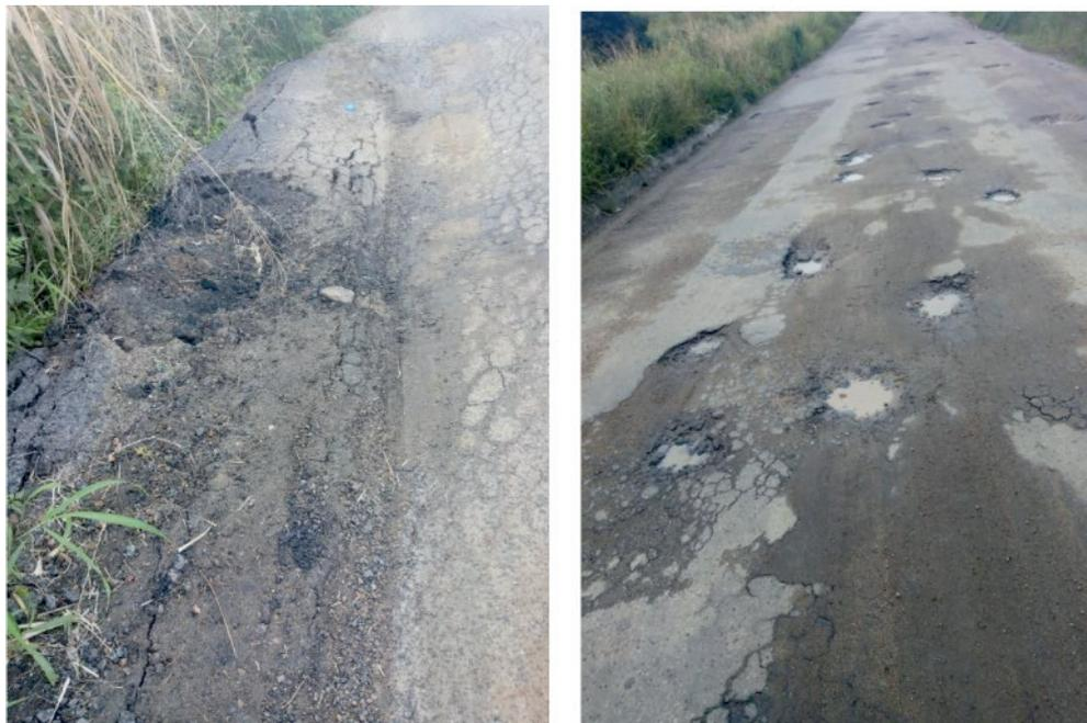
Figura 2 – Seções de alto estado de degradação nos Trechos analisados
