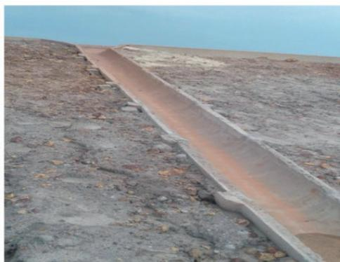
FIGURA 12 – Descida d'água
