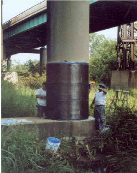
Figura 2: Encamisamento de pilar
