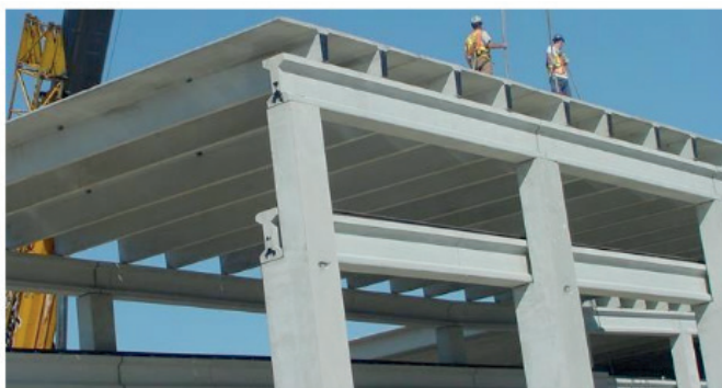
Figura 5: Aplicação de concreto
