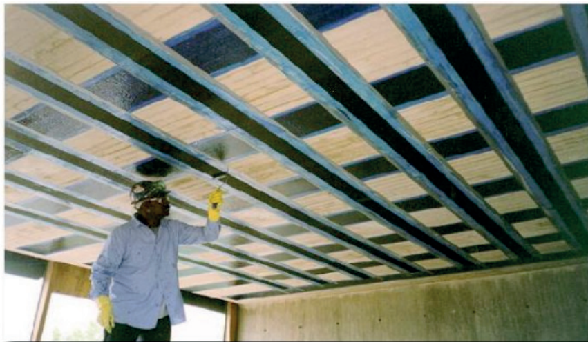
Figura 4: Reforço em lajes
