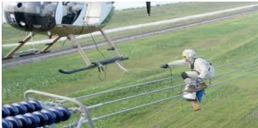
Figura 6 – Trabalhador em uma linha viva realizando a equalização
