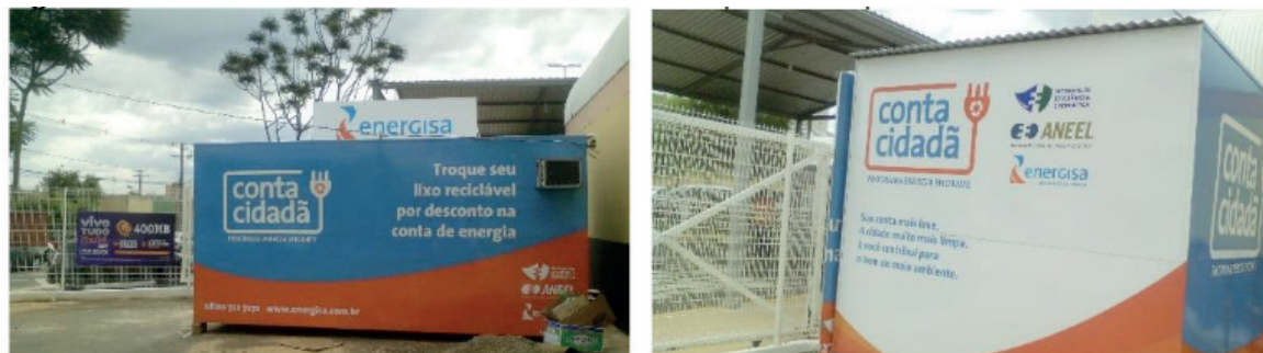
Figura 03: Pontos de Troca ENERGISA – Mercado Municipal de Campo Grande
