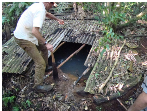
Figura 3: Nascente na propriedade 1 antes da aplicação da técnica solo-cimento Fonte: Os autores, 2015.
