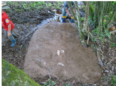
Figura 8: nascente propriedade 2 após a aplicação da técnica solo-cimento Fonte: Os autores, 2015.
