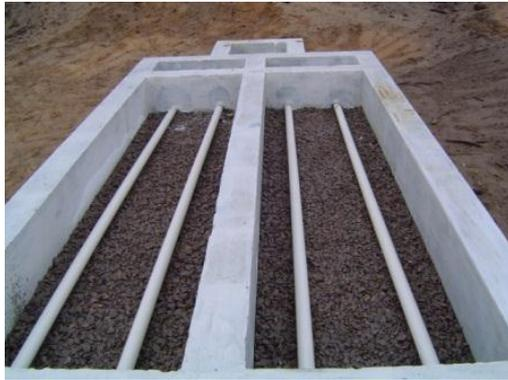
Figura 1: Biofiltos Submersos na época da construção
