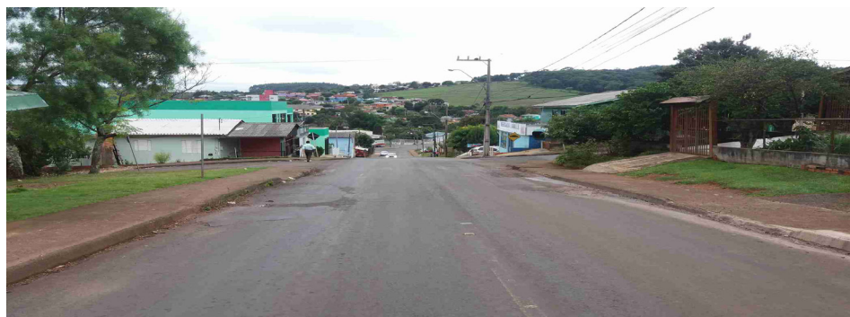
Figura 4: Vista da caixa de rua da Rua Kasulo – Bairro Seminário.
