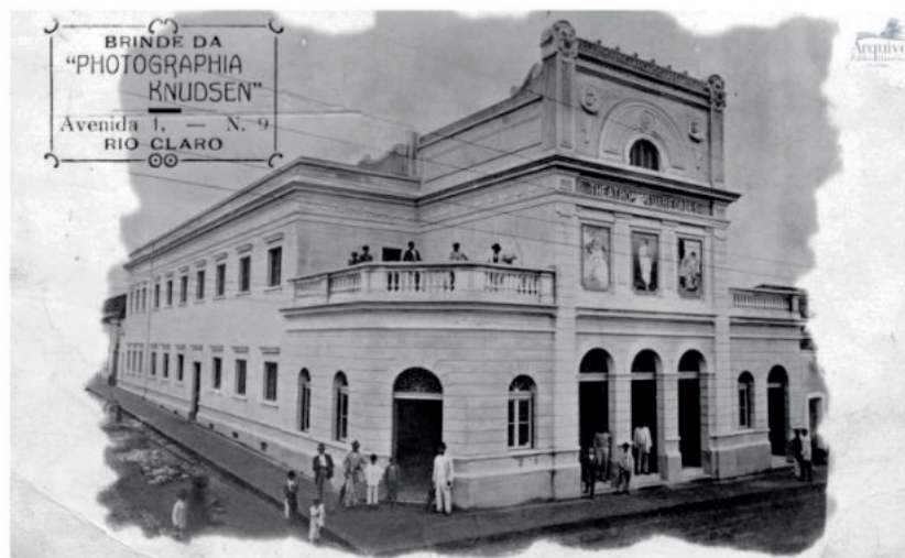
Figura 1 - Teatro Variedades conforme projeto original.
