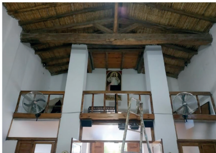
Fig. 4: Techo de madera y cañas. (Fuente: propia, 2019)
