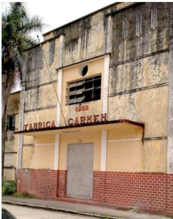
Figura 3: Prédio da fábrica Carmen após desocupação em 2017.
