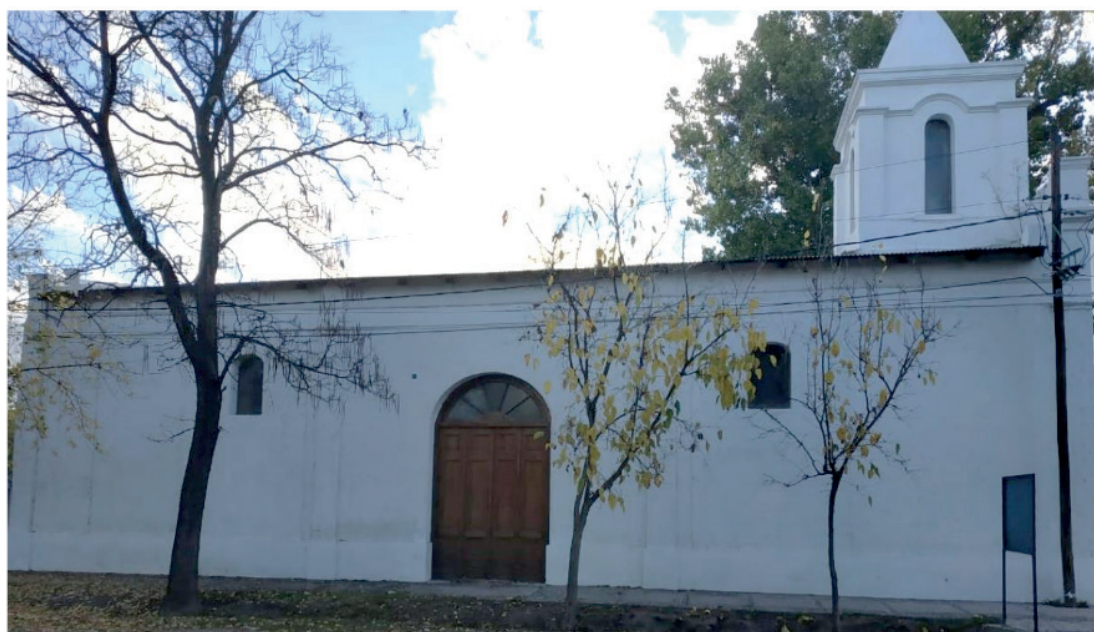
Fig. 2: Fachada Este de la Iglesia Parroquial Ntra. Sra. del Carmen. (Fuente: propia, 2019)
