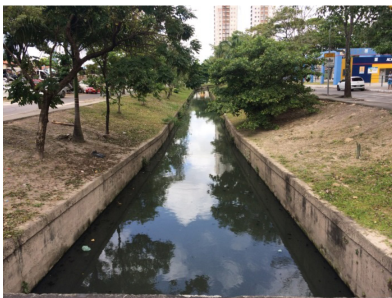
Figura 1 – Estrutura de canal e talude com vegetação no riacho do Cavouco no bairro do Cordeiro, Recife-PE.
