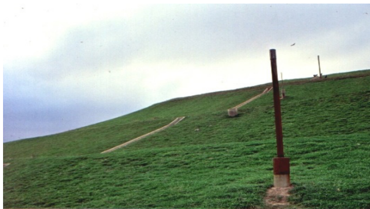
Figura 3 – Drenagem de chorume e de biogás de Curitiba, PR.
