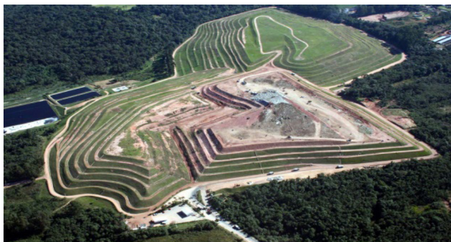
Figura 2 – Aterro Sanitário de Curitiba, PR.
