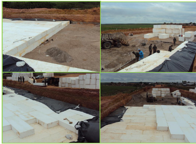
Figura 2. Metodologia executiva do aterro leve com EPS.
