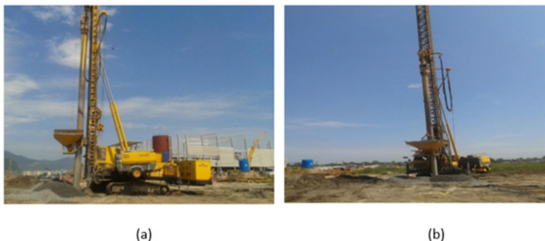
Figura 7 - Execução das colunas de brita no Centro Metropolitano. (a) vista lateral (b) vista frontal (ADAPTADO DE GEOCONSULT, 2012)
