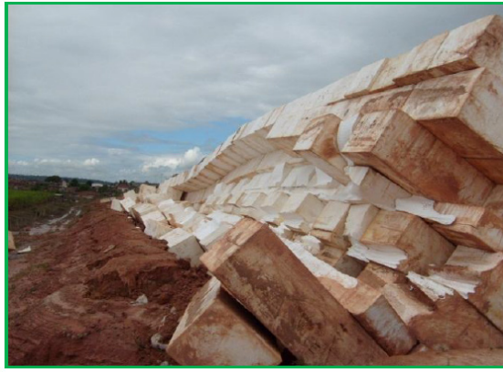
Figura 4. Aterro 3 rompido.
