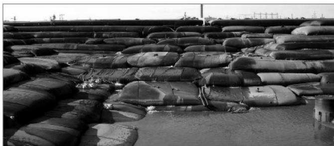
Figura 1. Empilhamento de Tubos têxtil em Salt Lake City (2009) – Maccaferri.
