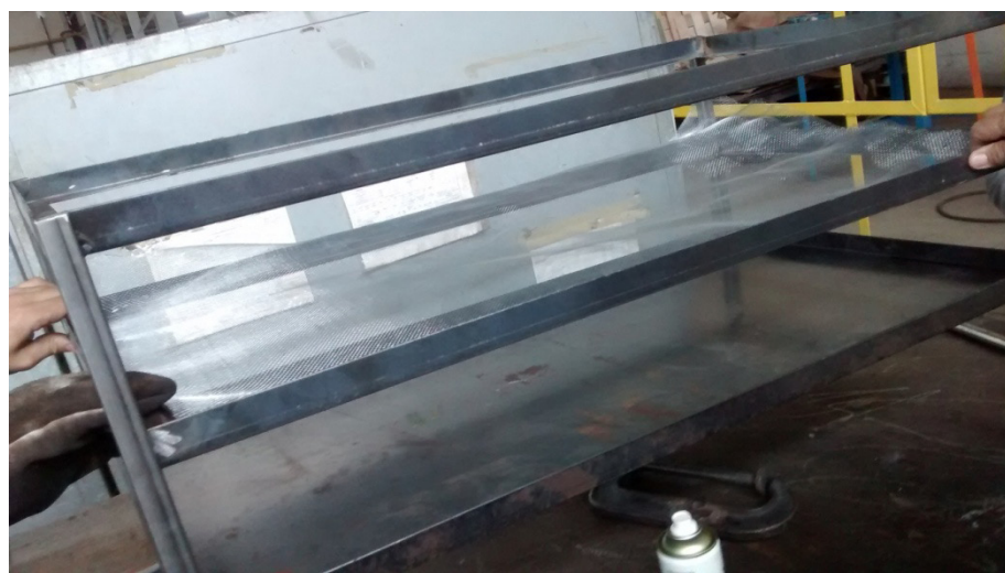
Figura 4: Instalação das Telas nos Quadros.
