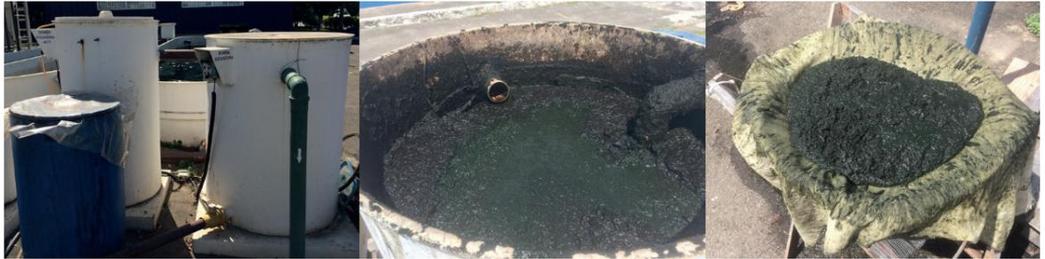
Figura 3. Sistema de coagulação-floculação da ETE Piloto
