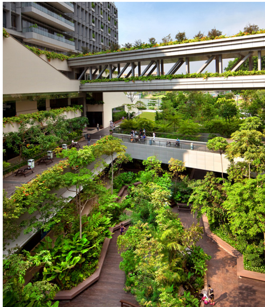
Figura 3 – Vista de um dos pátios internos descobertos do KTPH.
