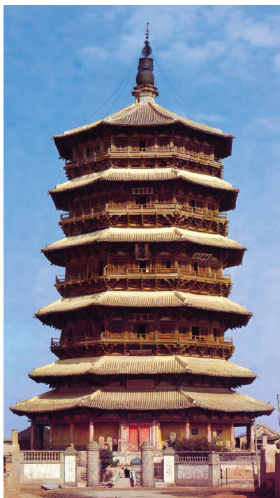
FIGURA 1: Pagode no condado de Ying, ao norte da província de Shanxi, 1056: a mais antiga e mais alta torre inteiramente construída em madeira do mundo (SHANGAI DAILY, 2018).
