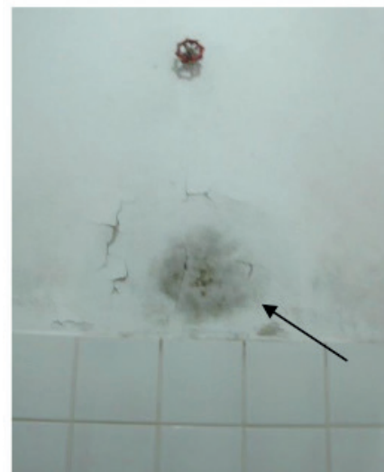
Figura 11 – Indícios de vazamentos por fissura ou ruptura de tubulações embutidas
