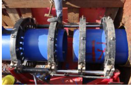
Figura 3: Execução Solda de Termofusão
