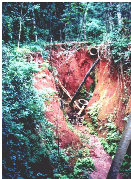
Figura 1: Cabeceira da ravina da Av. Paraná, evidenciando-se, no fundo o coletor de águas pluviais.
