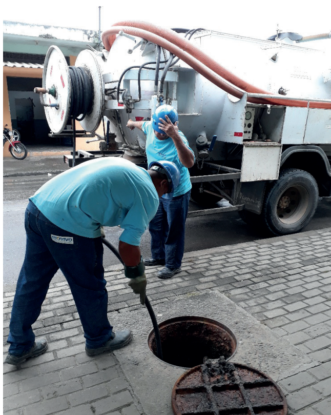
Figura 10. Desobstrução de rede de esgoto da Companhia com água de reúso.
