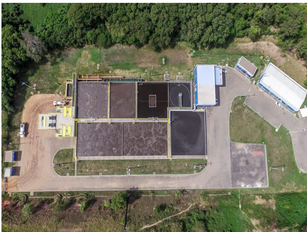
Figura 1. Vista aérea ETE Bandeirantes.
