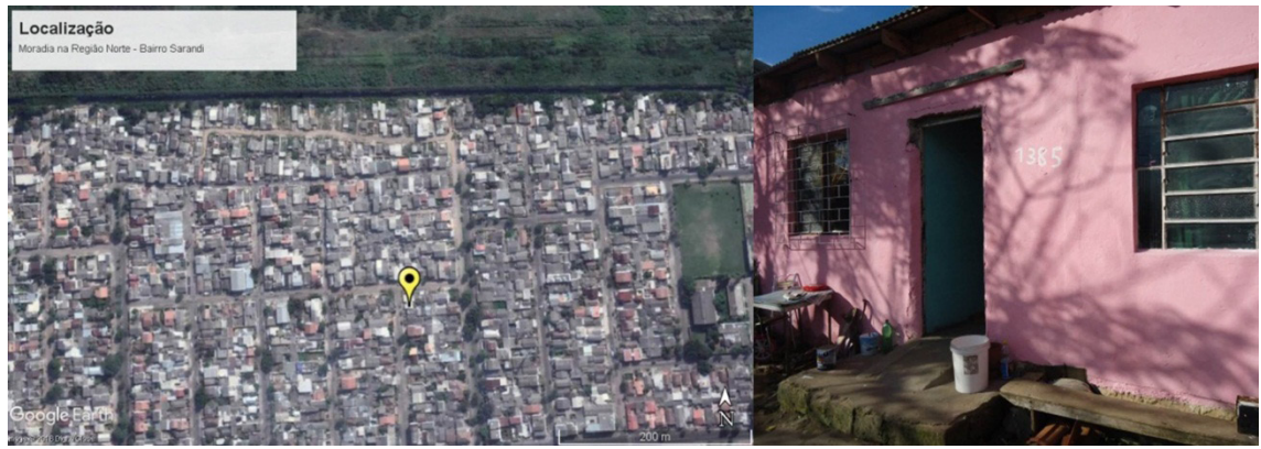
Figura 3: Casa localizada na Região Norte. Fonte: GOOGLE EARTH; ASCPOA.
