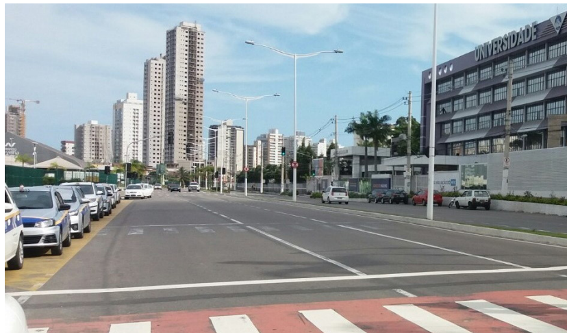
Figura 14 – Rua Juscelino Kubistchek, vista do trecho da rua onde observa-se à direita, o edifício de uma universidade; ao fundo, parte dos edifícios que foram construídos posteriormente.
