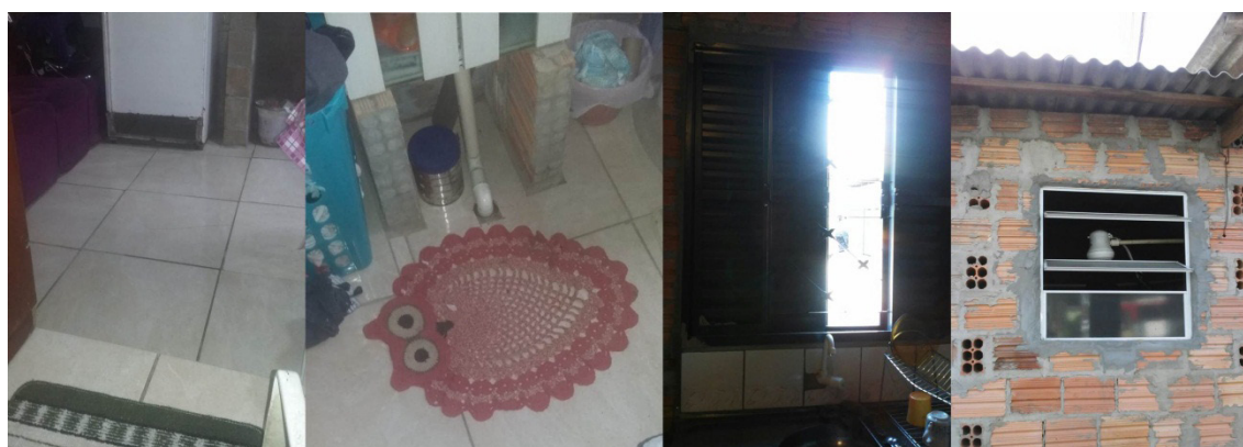
Figura 8: Piso colocado, novas esquadrias e rede hidráulica instalada. Fonte: ASCPOA.
