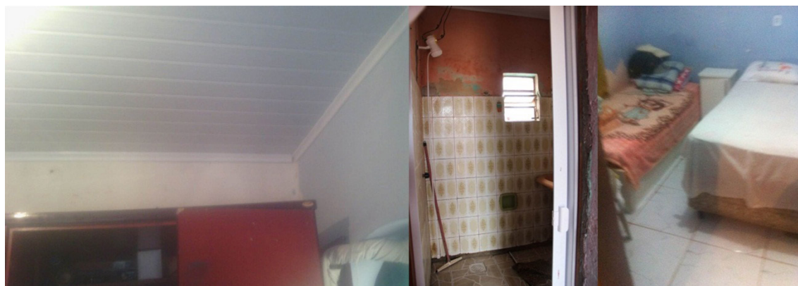
Figura 5: Forro colocado, banheiro reformulado e novo piso dos quartos. Fonte: ASCPOA.
