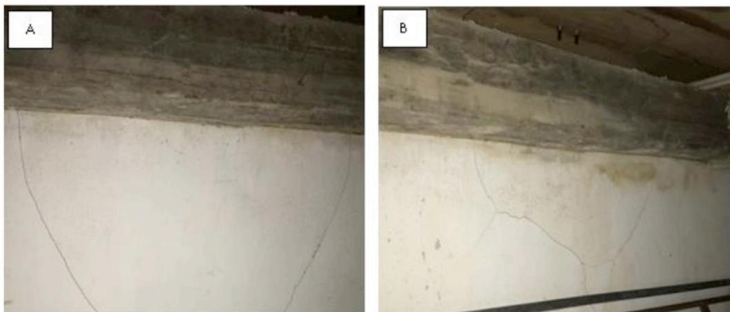
Figura 4 – (A) Fissuras em parede; e (B) Fissuras e manchas em parede.
