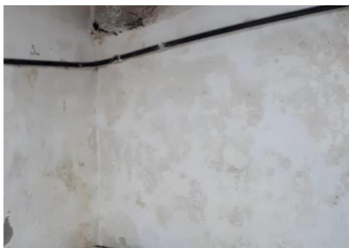
Figura 5 – Descascamento da pintura em paredes internas.
