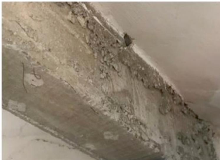
Figura 6 – Viga da sala de ensaios com concreto segregado aderido à face.
