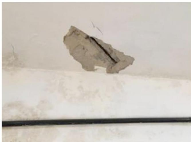
Figura 3 – Laje da sala de ensaios com armadura exposta e deslocamento de concreto.
