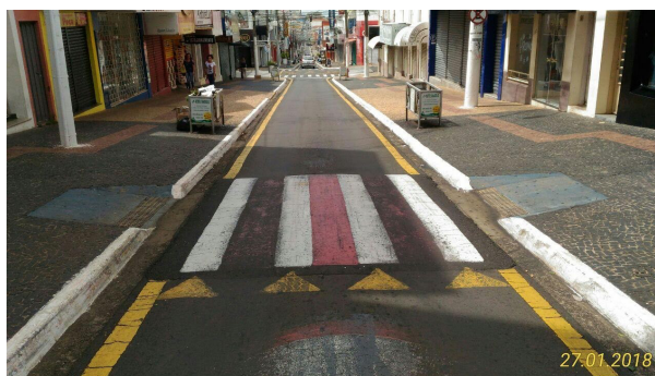
Figura 1 - Conflito de interesse, rampa de acessibilidade direcionada a lombada
