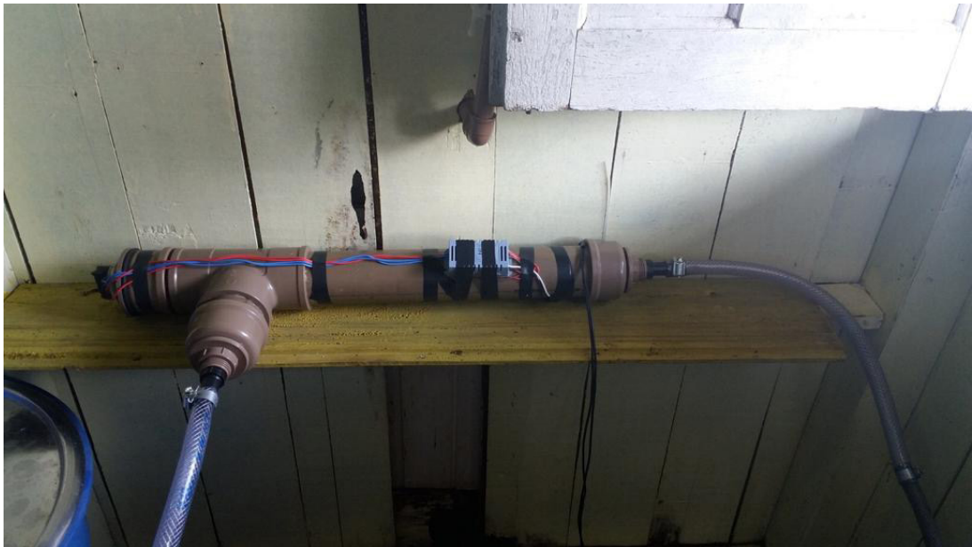
Figura 5: Filtro UV após a instalação
