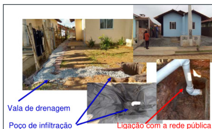
Imagem 7 - Representa a execução do sistema de drenagem no solo (imagens do autor)
