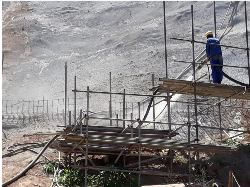
Figura 3: Concreto sendo projetado.
