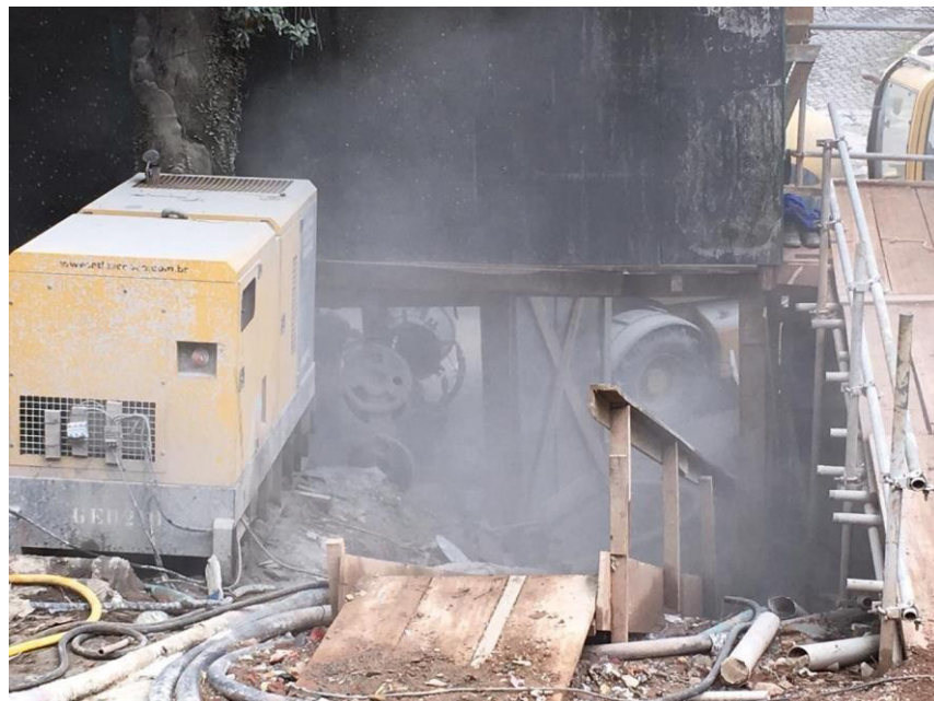
Figura 4: Levantamento de poeira devido a mistura seca.
