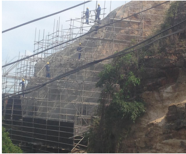
Figura 2: Encosta onde o concreto projetado por via seca será aplicado.
