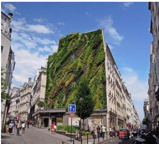
Figura 4: Fachada em movimentos através das plantas.
