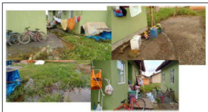
Imagem 4 – Água parada no fundo do lote, sistema de drenagem executado pelo beneficiário.
