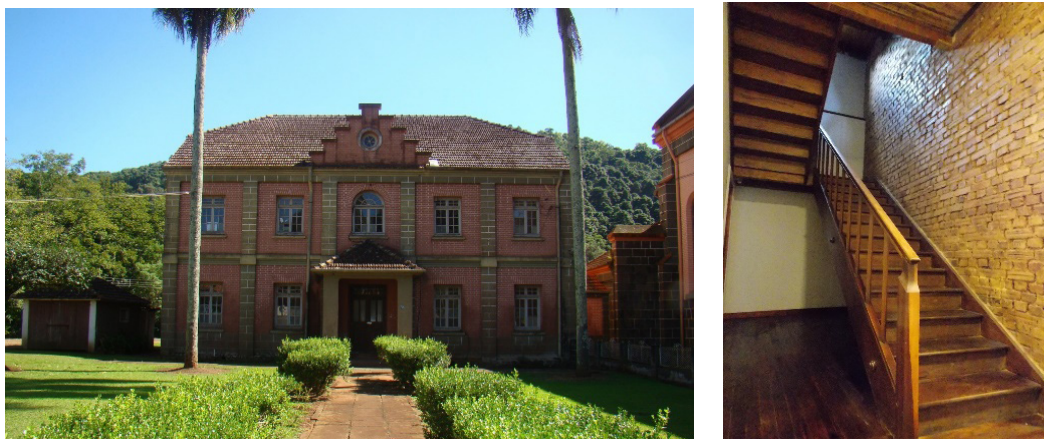
Casa Canônica após a conclusão das obras de restauro
