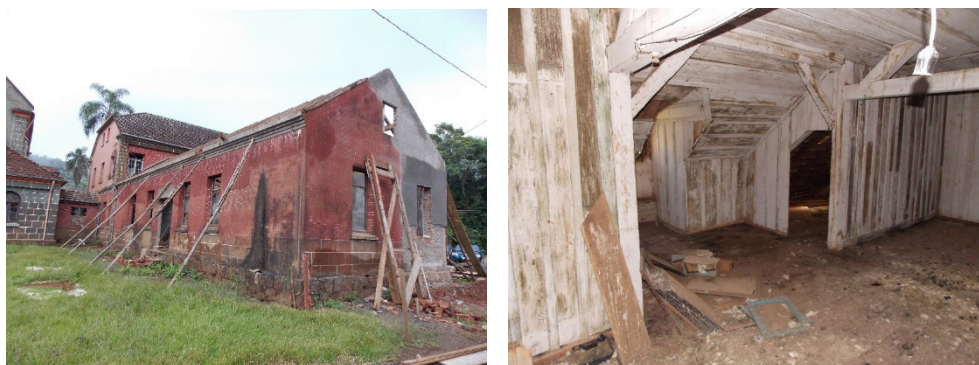
Casa Canônica antes e no início das obras de restauro
