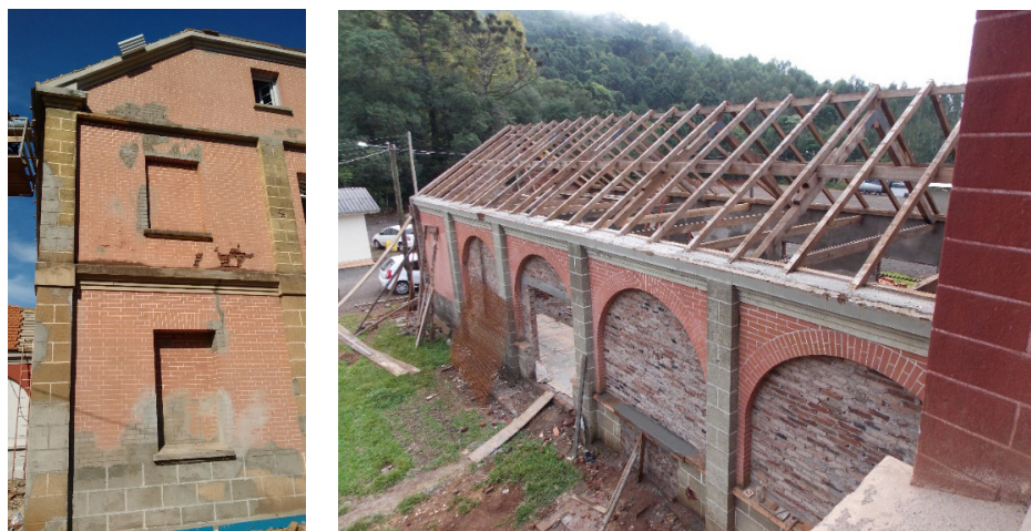
Casa Canônica durante as obras de restauro
