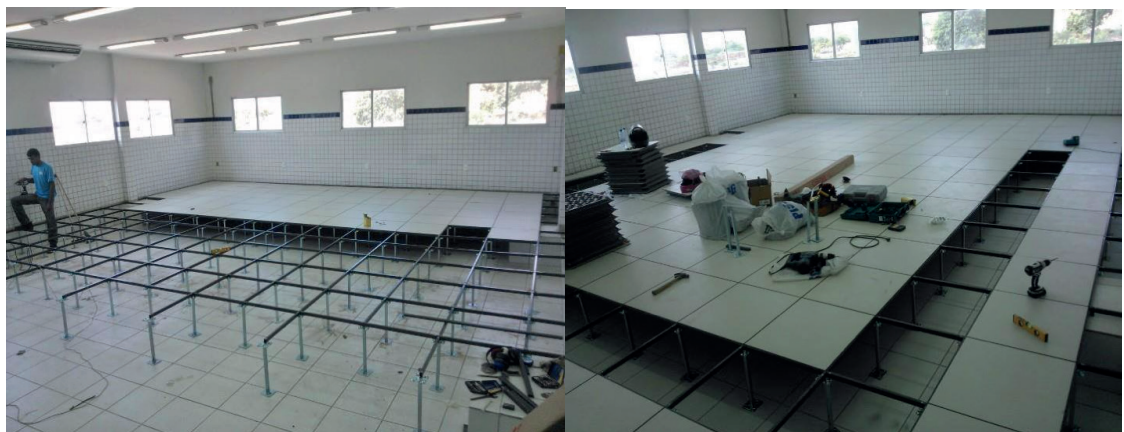
Figura 3 - Montagem do piso suspenso.
