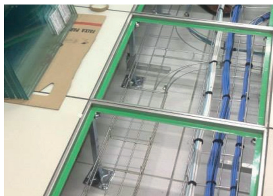
Figura 5 - Cabeamento reorganizado
